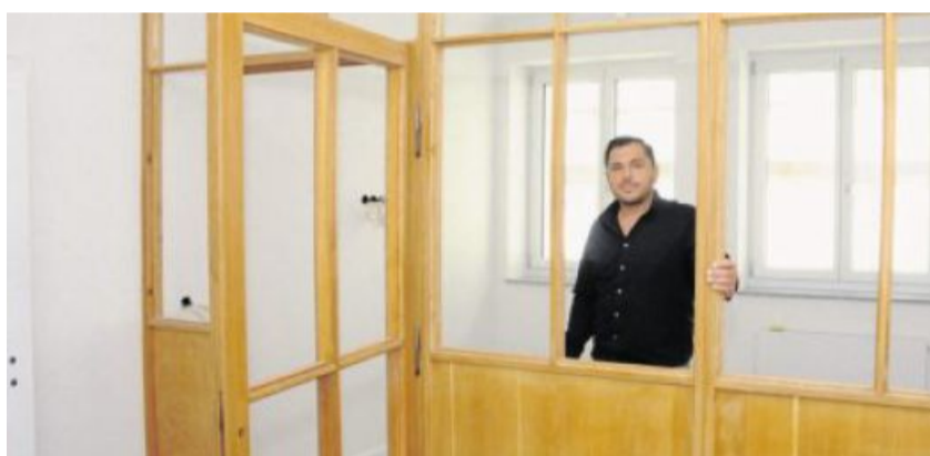
Die Holz-Elemente aus Eiche sind aufbereitet und werden in die neuen Verwaltungsräume integriert. Ludwig Hetzenegger siedelt hier die Buchhaltung seiner Firmen an. Bild: Gebhardt
